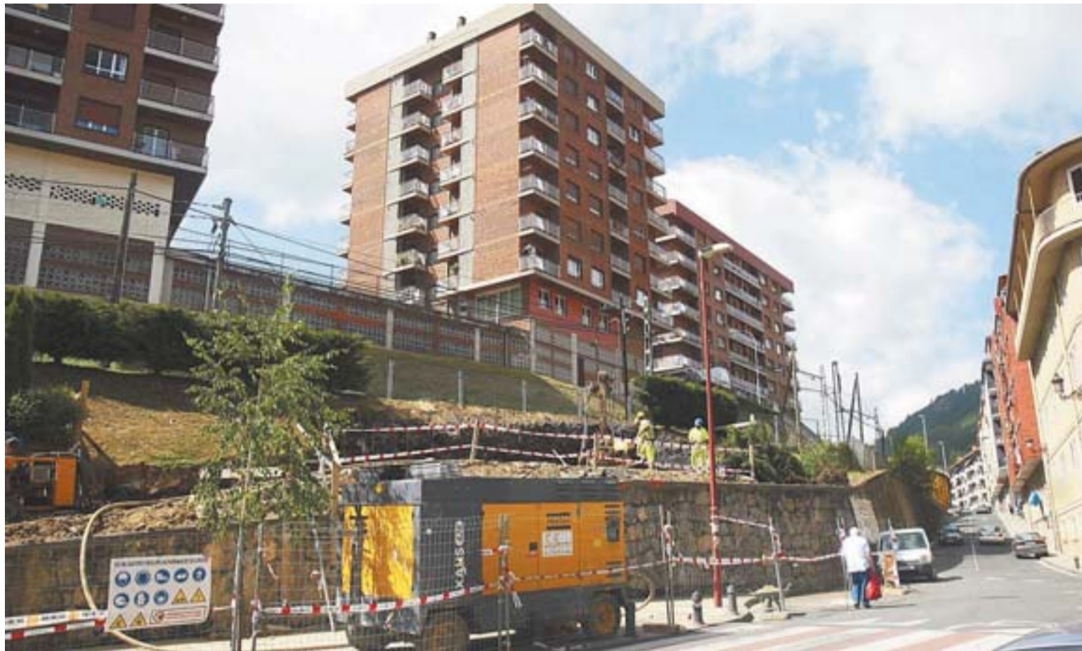
Altura. El ascensor salvará una diferencia de cota de 15,32 metros, una vez que las obras estén finalizadas y entre en funcionamiento. :: A.Z.
